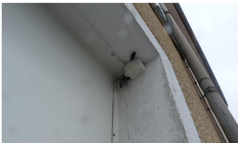
Ci-contre : photo de la position de la sonde extérieure. (Sous linteau porte de garage, façade Nord)
