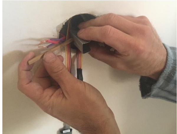
Positionnement et libération de TH2 derrière le freine-vapeur
