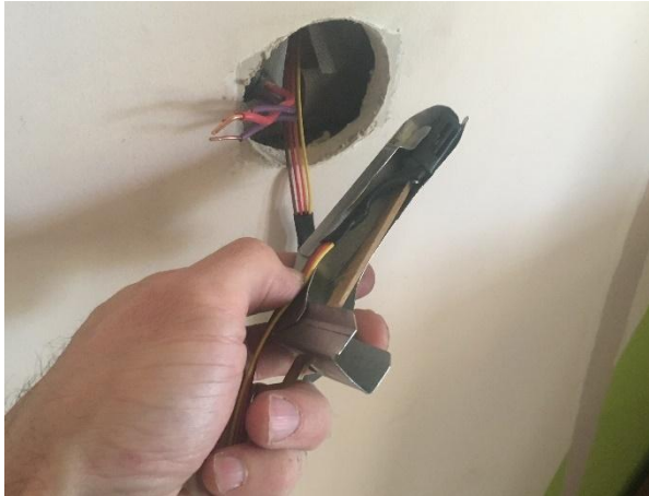
Fourre-sonde coudé pour passer entre l'isolant et le freine-vapeur
