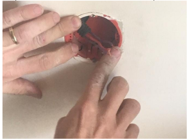
Remise en place du boîtier électrique et de l'appareillage
