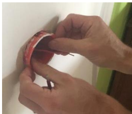
Démontage d'une prise ou d'un interrupteur
