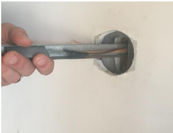
Positionnement de la sonde TH1 rallongée contre le mur
