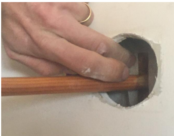
Création d'un passage dans l'isolant
